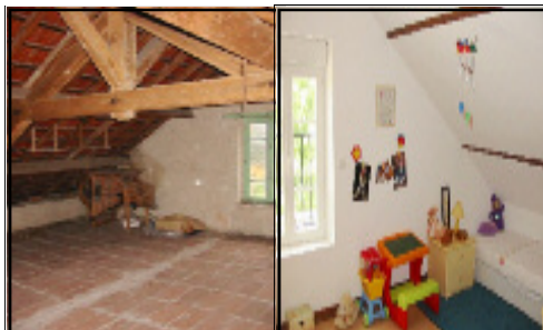
Avant et après travaux
