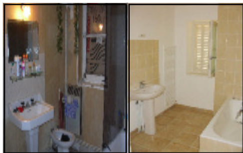
Avant et après travaux
