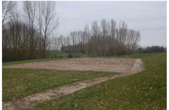
Station d'assainissement collectif de Courcelles – Crédit photo Aequilibrium Conseil
